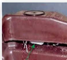
Le flotteur coupe l'arrivée d'eau
